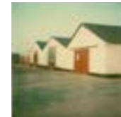
Bau einer neuen Produktionshalle in Achtmaal
