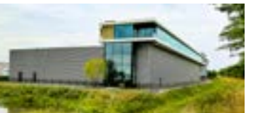
Auf dem Patagonweg in Etten-Leur wird ein neues Werk für die Produktion von Pitbull Kompaktlader und Biga Topliner in Betrieb genommen
