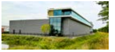
Une nouvelle usine de production de chargeuses compactes Pitbull et de Biga Topliner est mise en service sur le Patagonweg à Etten-leur
